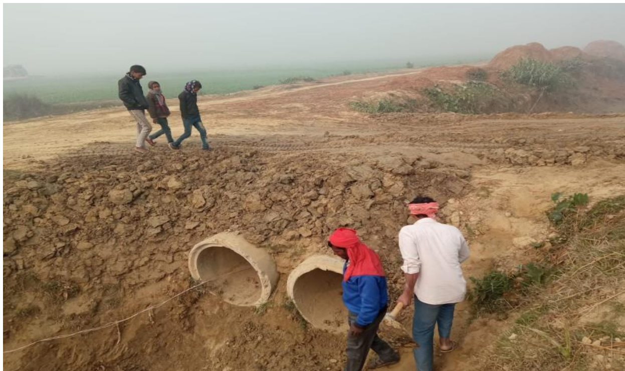
सडक तथा कल्भर्ट मर्मत आयोजना, वडा नं. ८
